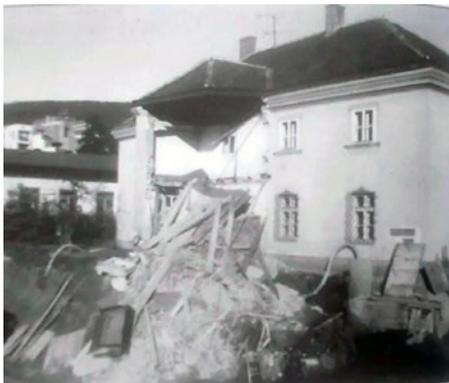
Der Erker vom Pfarrhof: Im Zuge der Bauarbeiten der Purkersdorfer Umfahrung stürzte im November 1984 plötzlich der Erker in den Gablitzbach. 1987 erfolgte der Neubau des Erkers. Aktuell wird eine Reparatur wegen Sprüngen an den Säulen notwendig.
